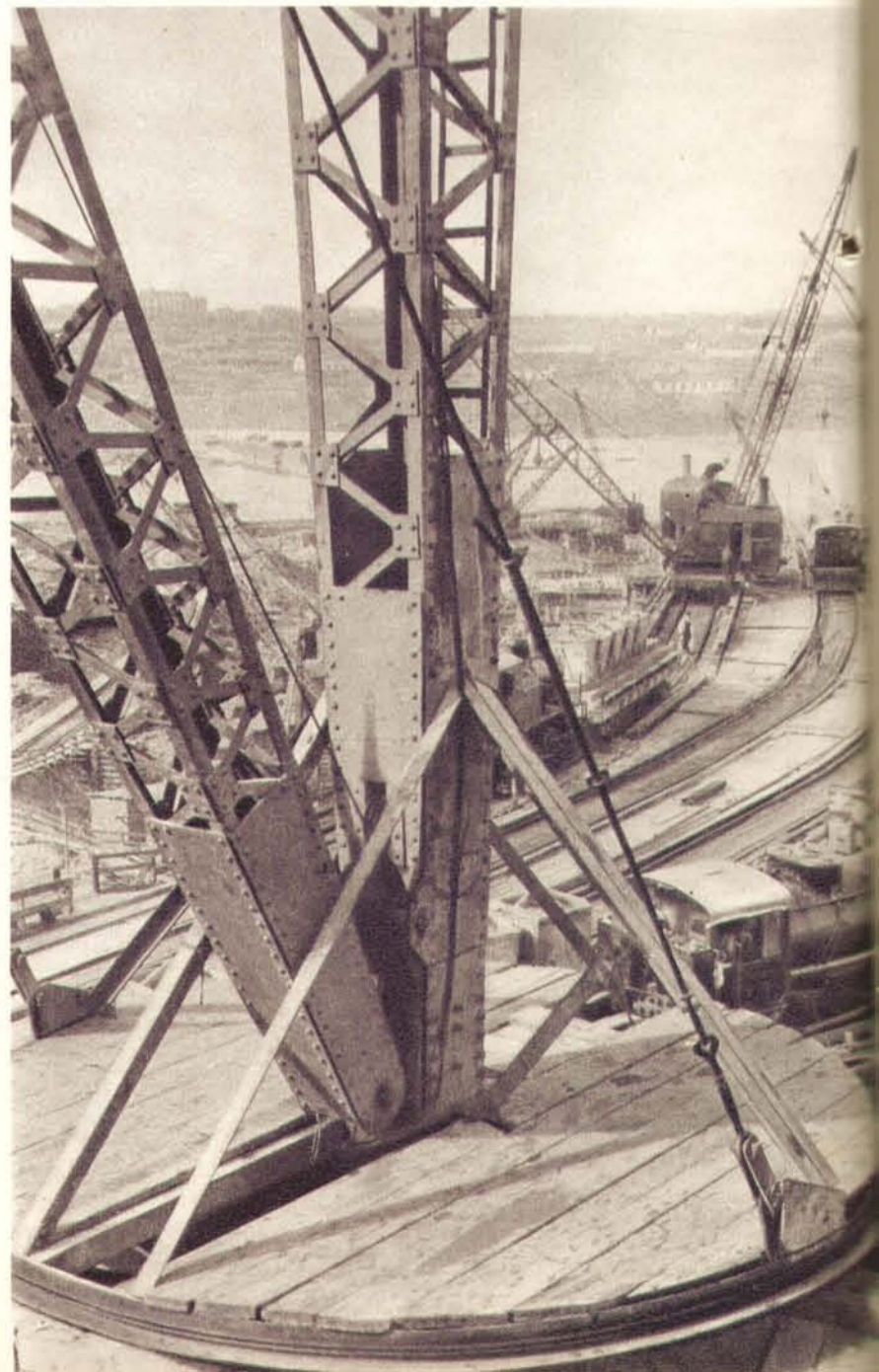
На нижнем снимке — строительство Днепровской гидроэлектростанции имени В. И. Ленина (снимок 1929 года).
