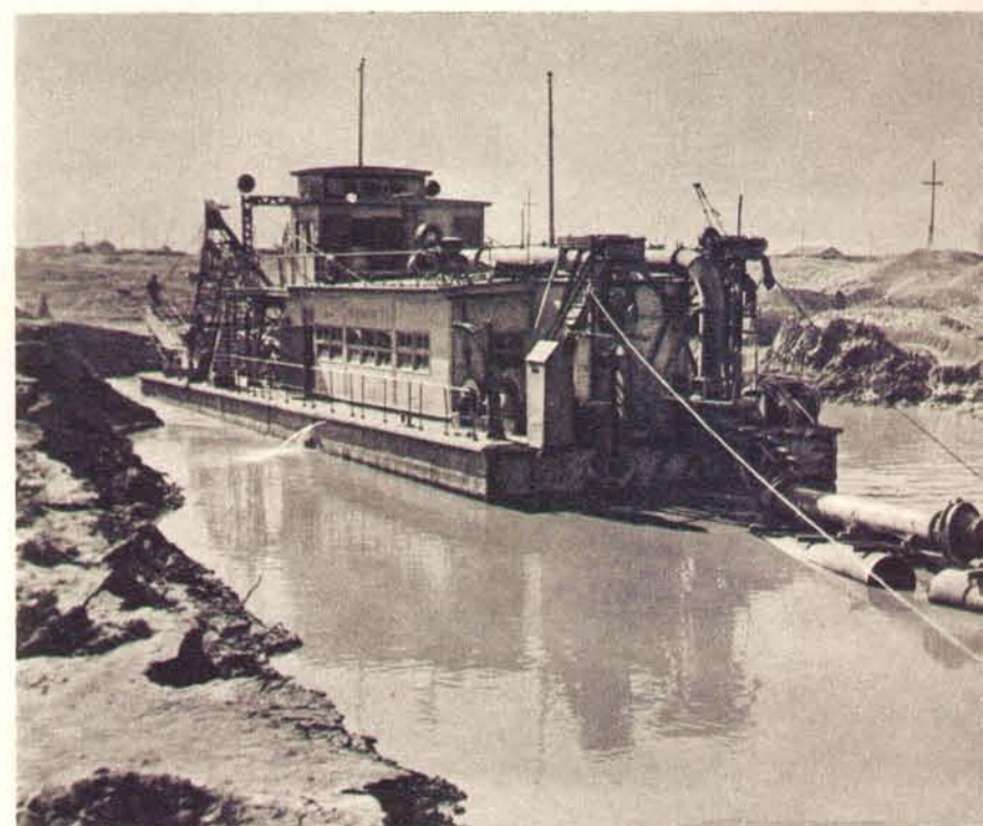
Электрические землесосные снаряды работают на сооружении новых гидроузлов.
